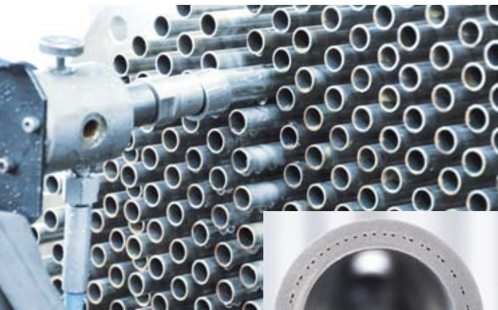
Hydraulisches Aufweiten des Rohrpaares
