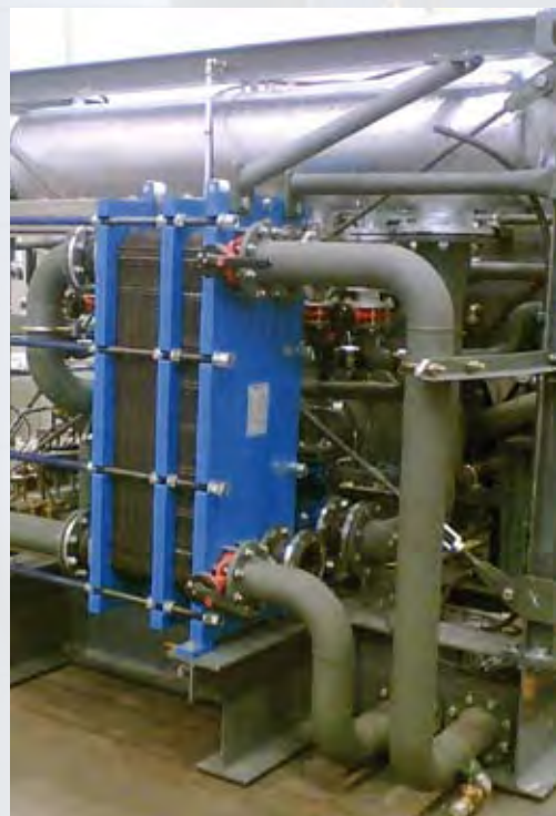
Refroidissement d'huile hydraulique pour compresseurs d'air à haute pression dans l'exploitation pétrolière.
